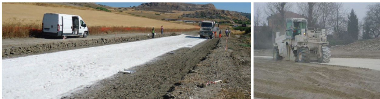
Figura 5-1 Esecuzione del trattamento a calce in linea
